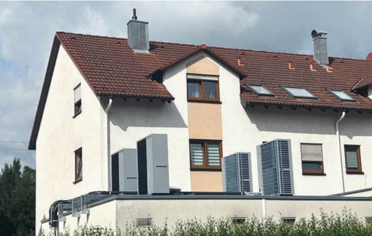
✔ Installation von Wärmepumpen in der Taunusstraße 10/12 in Wasseralfingen
