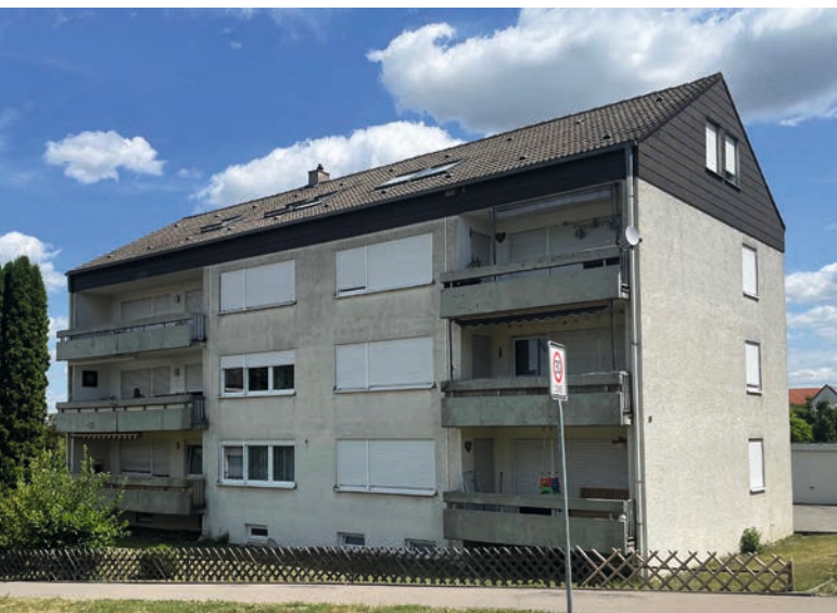
☑ Beethovenstraße 12 in Westhausen vor der Sanierung.
