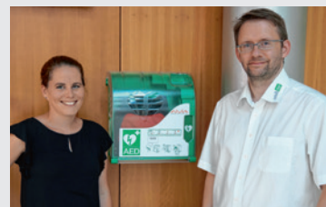
Jessica Barth (Abteilungsleiterin Gebäudewirtschaft, Kreisbau) und Jochen Schittenhelm (Firma Ostalb Med) mit dem neu installierten Defibrillator.
