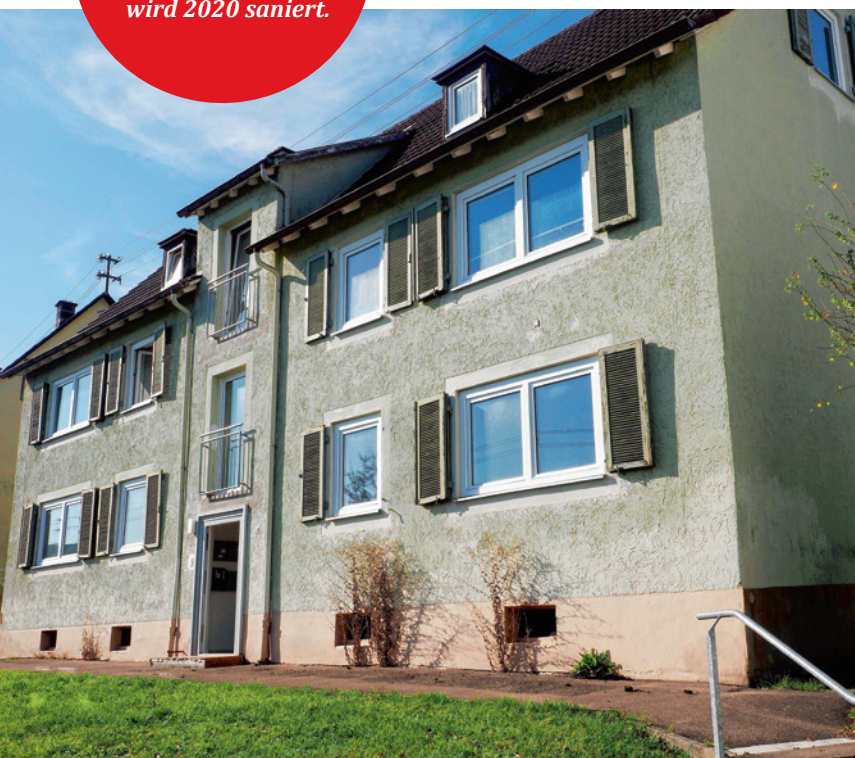
Das Gebäude in der Brunnenhaldestraße 30 in Oberkochen vor den Modernisierungs- und Sanierungsarbeiten.
