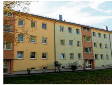
Abwaschen statt Streichen: Die Fassade in der Heinz-Küppenbender-Straße erstrahlt in neuem Glanz.
