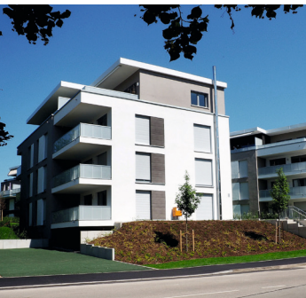
Der 2. Bauabschnitt der Wohnanlage „Wohnen im Park“ wurde Ende 2018 fertiggestellt.
